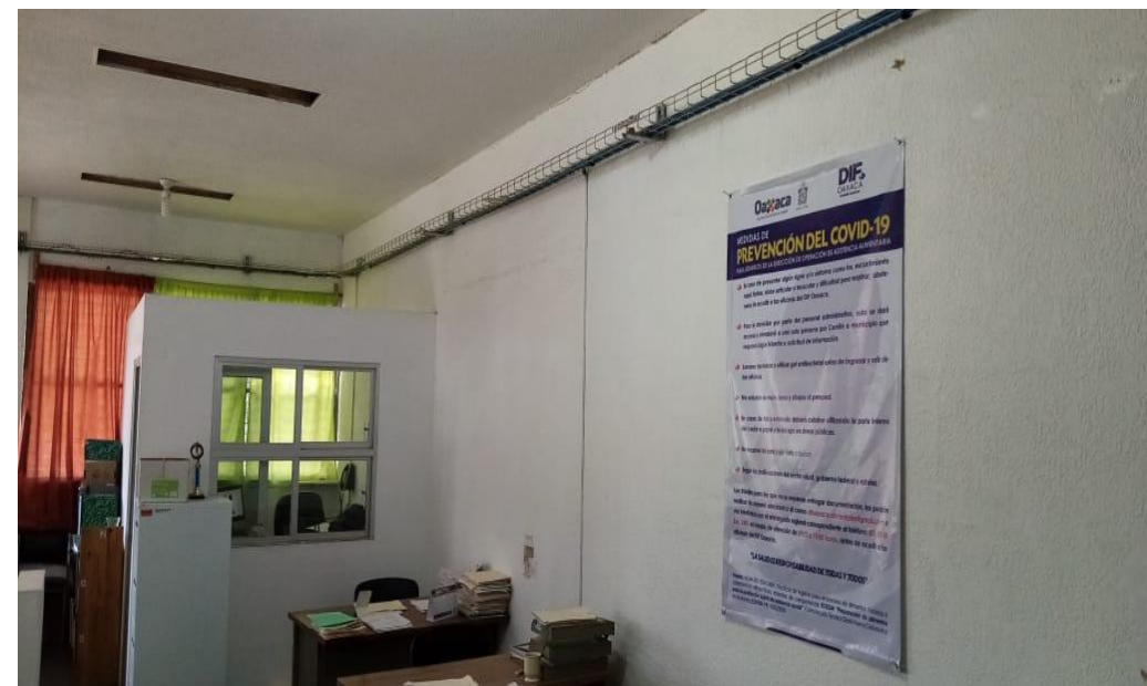
Foto: Colocación de lonas en el interior de la Dirección de Operación de Asistencia Alimentaria
